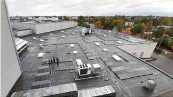
PV-Anlage auf dem Paunsdorf-Center
